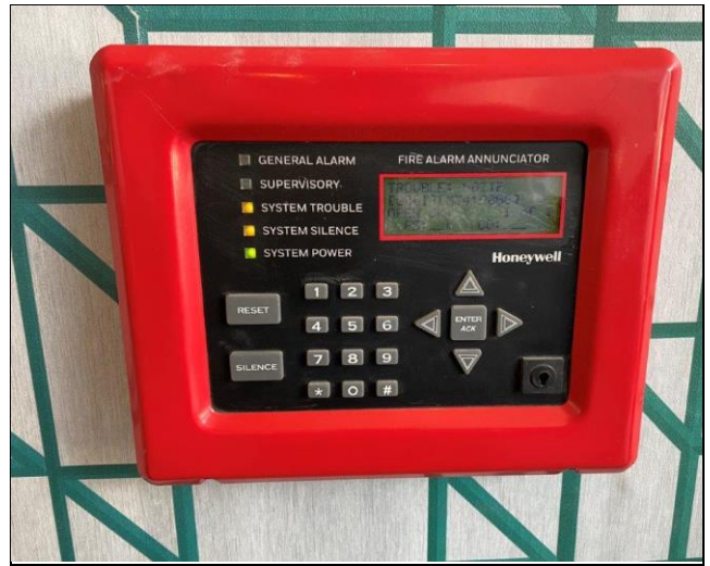
86. Fire alarm annunciator
